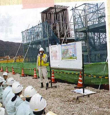
堤防護岸工事、MAGロード橋脚工事などを見学し、河川整備に対する重要性を学びました
