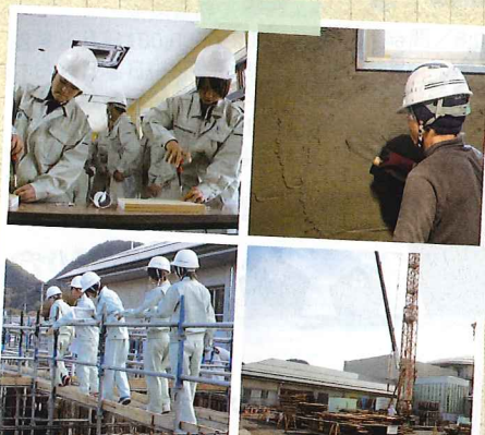
老人福祉施設および病院外来棟等の増築工事を見学し、ボードにネジを差し込む体験をしました
